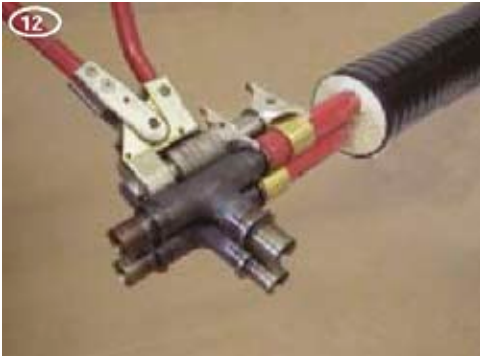
Nasunąć narzędziem pierścienie ślizgowe.
