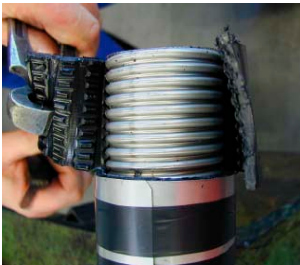
rys.6 Usuwanie płaszczu PE
