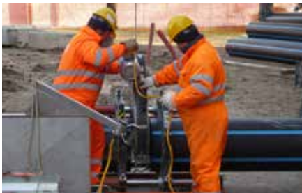
Verschweißen der Mantelrohrstangen
