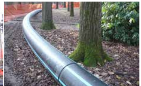
Bereit für die grabenlose Verlegung
