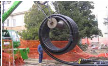
Abwicklung und Verlegung in einem
