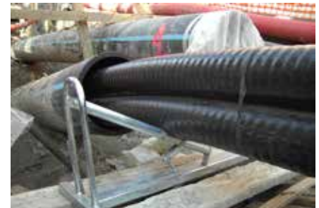
Die Rohrleitungen beim Einfügen in das PE-HD-Mantelrohr
