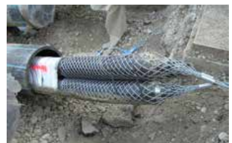
CASAFLEX Rohrleitung verlässt das Mantelrohr nach einer durchgehenden Strecke von 190 Metern.
