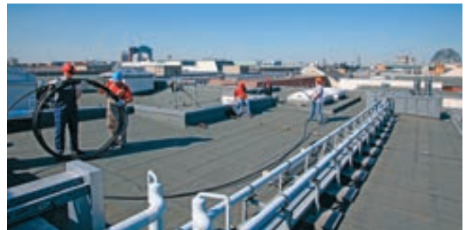
Verlegung vom Ring am und im Gebäude
