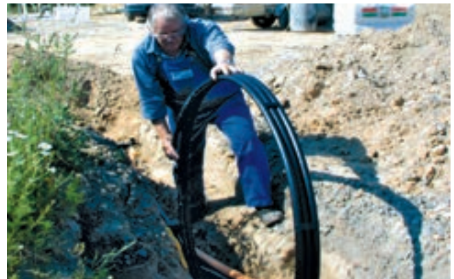
Verlegung vom Ring direkt in den Graben
