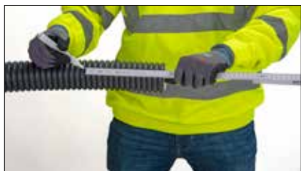
1 Marquer le manteau à la distance (x, y, z) +1 cm de l'extrémité du tube.
