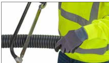
2 Couper la gaine extérieure avec une scie.
