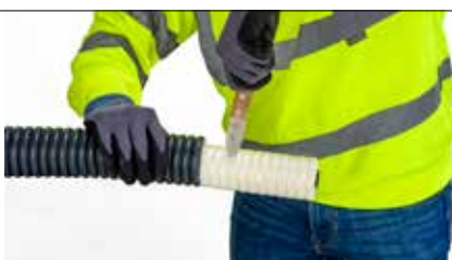
5 Couper/enlever l'isolation sur la longueur (x, y, z). Attention : Ne pas abîmer le tube médian !
