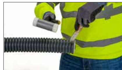
3 Découper la gaine longitudinalement. Introduire le couteau à une profondeur max. de 5 mm. Attention : Ne pas abîmer le tube médian !
