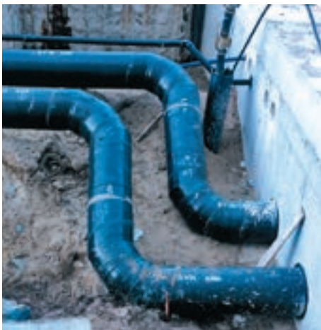
Anschluss der Technikzentrale an die Kühlleitung
