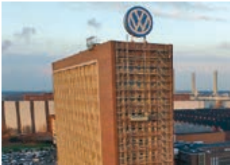
Das VW-Verwaltungs-hochhaus in Wolfsburg
