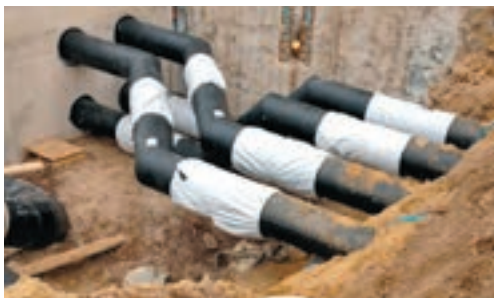
Anschluss der Technikzentrale an die Kaltwasserversorgung mit PREMANT®
