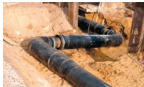
BRUGG-STAMANT®-Sicherheitsrohr mit Montage-Dehnungselement
