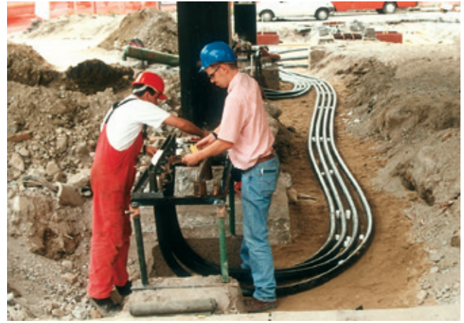
Montage der Anschluss-technik auf der Baustelle
