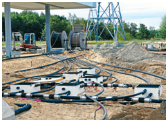
Verlegung der Füllleitungen direkt von der Trommel
