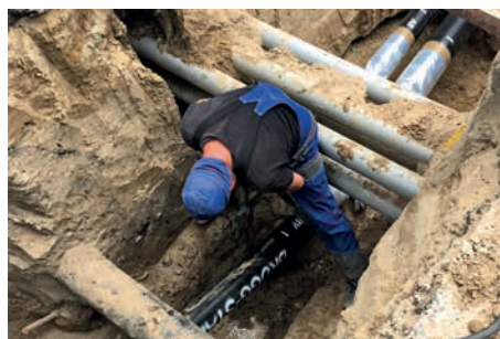
Fachgerechte Anbindung an die bestehende BRUGG-STAMANT®- Sicherheitsrohrleitung
