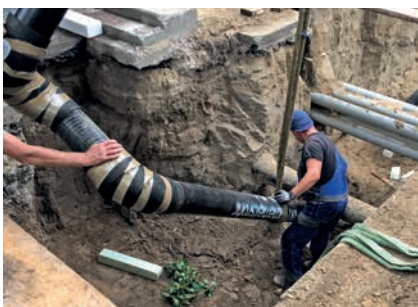
Verlegung des BRUGG-STAMANT®-Sicherheitsrohres mit viel Fingerspitzengefühl
