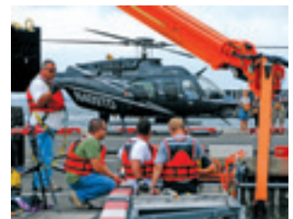
Installationsarbeiten bei vollem Flugbetrieb
