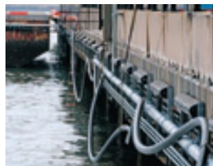
Provisorisches Verlegen der FLEXWELL-HL Rohrleitung
