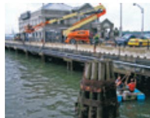
Endgültige Befestigung der Rohrleitung an der Pier
