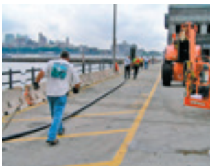
Auslegen von 170 m FLEXWELL-HL Rohrleitung
