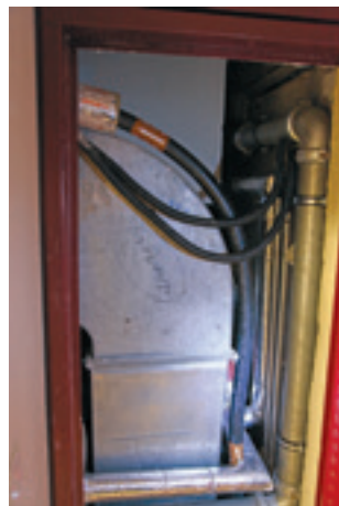
Trotz enger Verhältnisse im Gebäude: Verlegung in einem Stück
