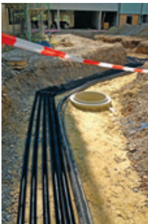
Verlegung im Graben
