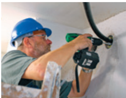
Abschottung des FLEXWELL-Sicherheitsrohres® mit bauartzugelassener Brandschutzdurchführung
