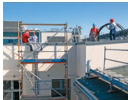
Dank hoher Flexibilität problemlose Verlegung über die Dachkante mit mehrfacher Richtungsänderung
