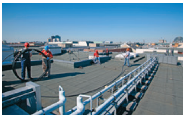
Verlegung des FLEXWELL-Sicherheitsrohres® auf dem Dach
