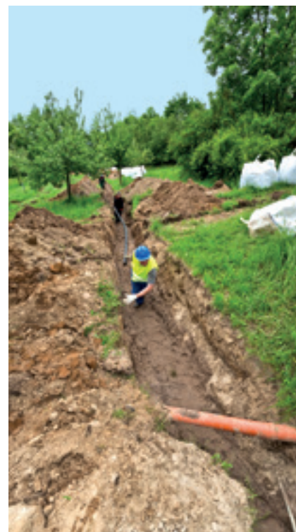
Der geringe Aushub schont das Ökosystem
