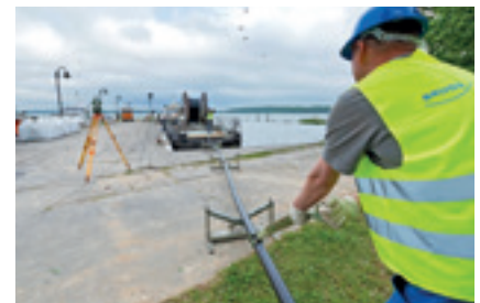
Abtrommeln der Rohrleitung
