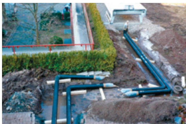
Baueinheiten im Rohrgraben
