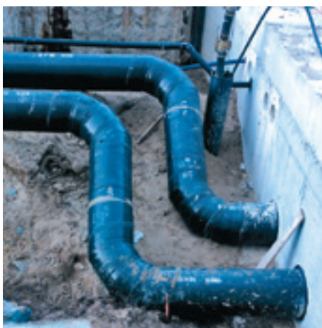
Anschluss der Technikzentrale an die Kühlleitung
