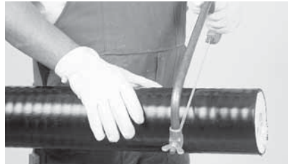
2 Mantel mit Säge durchtrennen.
