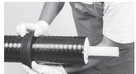
6 Mauerdichtring montieren.
