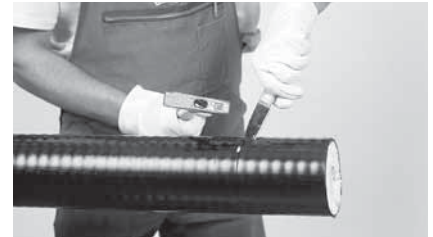
3 Mantel längs aufschneiden. Messer max. 5 mm tief einstecken.
