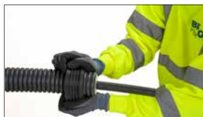
6 Mauerdichtung montieren.
