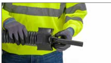
7 Rohrendabschluss sorgfältig aufschumpfen nach beigelegter Raychem DHEC Montage-Anleitung.
