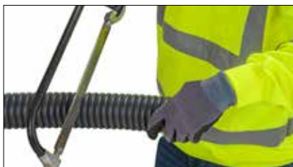
2 Mantel mit Säge durchtrennen.
