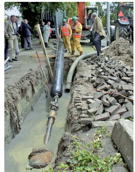
Verlegung des FLEXWELL-Fernheizkabel mit dem Horizontalspülbohrverfahren.
