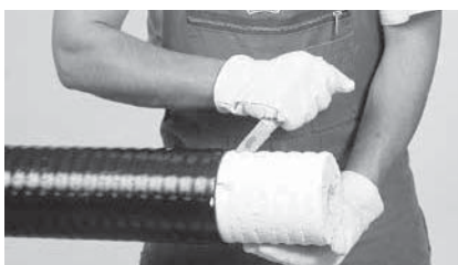
5 Enlever l'isolation sur la longueur (x, y, z). Achtung: Mediumrohr nicht verletzen!
