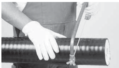
2 Couper la gaine extérieure avec une scie.
