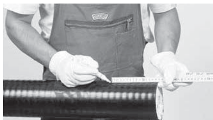
1 Marquer le manteau à la distance (x, y, z) +1 cm de l'extrémité du tube.
