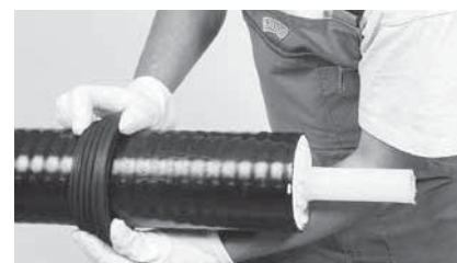
6 Monter le joint d'étanchéité mural.
