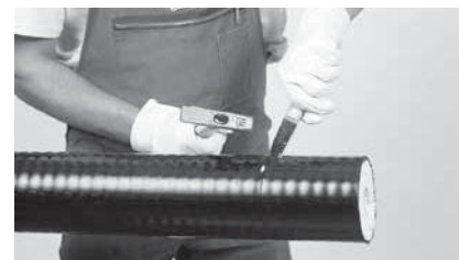
3 Découper le tronçon de gaine séparé longitudinalement. Introduire le couteau à une profondeur max. de 5 mm.
