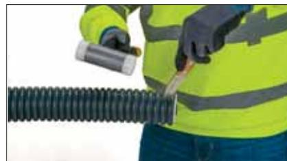
3 Découper la gaine longitudinalement. Introduire le couteau à une profondeur max. de 5 mm.
